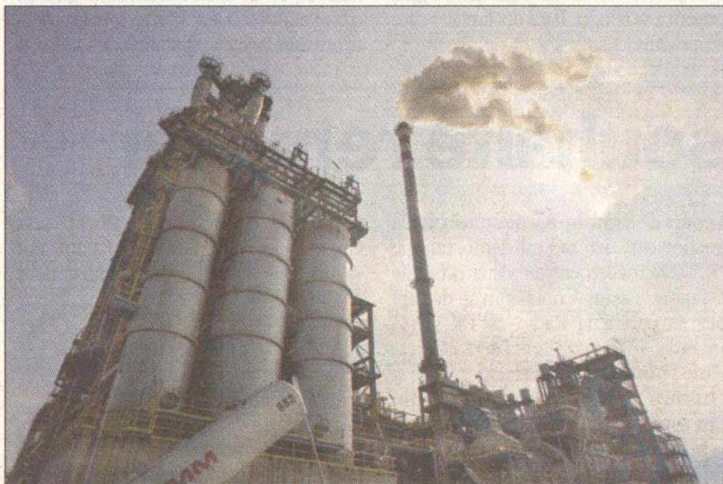
La raffinerie de Collombey a été entièrement nettoyée et inspectée. Patrick Martin
