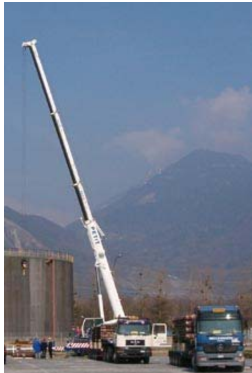
Déchargement des modules
