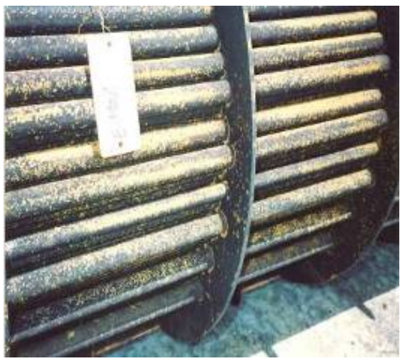
Echangeur propre, prêt pour l'inspection
