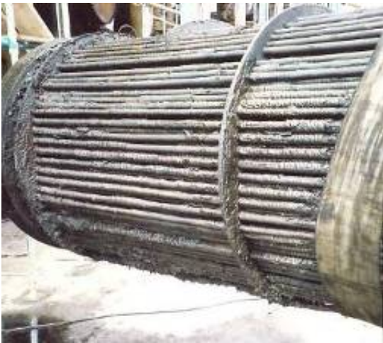
Un échangeur avant le nettoyage
